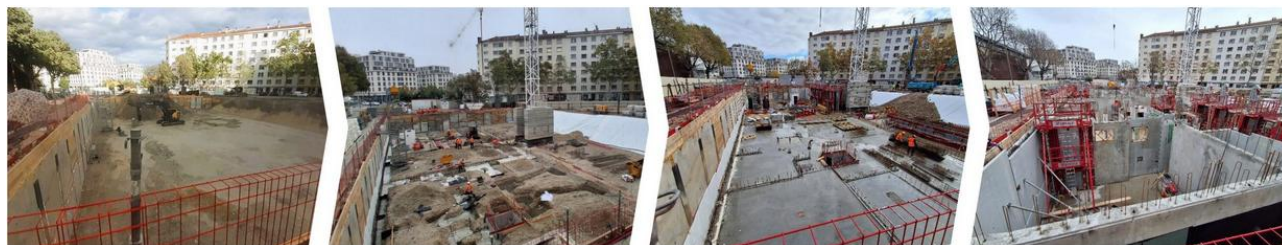
Avancement des travaux à Madeleine.
